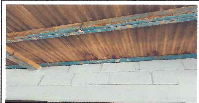
MANTENIMIENTO DE ESTRUCTURA Y SOPORTE DE METAL Y CAMBIO DE LÁMINA POR LÁMINA TROQUELADA
