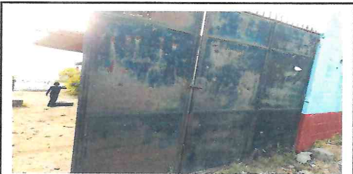
MANTENIMIENTO A PORTONES DE METAL
