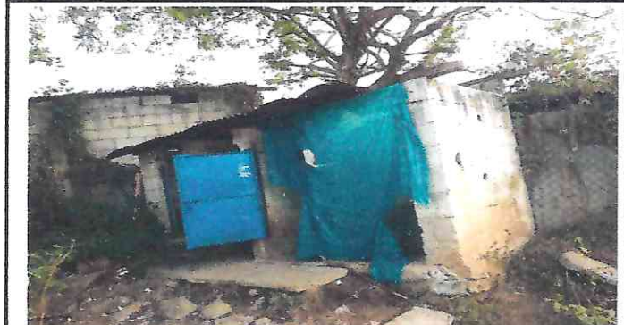
SUSTITUCIÓN DE PAREDES , PUERTAS, SUSTITUCIÓN DE LÁMINA POR LAMINA TROQUELADA Y SUSTITUCIÓN DE ESTRUCTURA DE MADERA POR METAL, SUSTITUCION DE PLANCHAS Y LETRINAS NO LAVABLES
